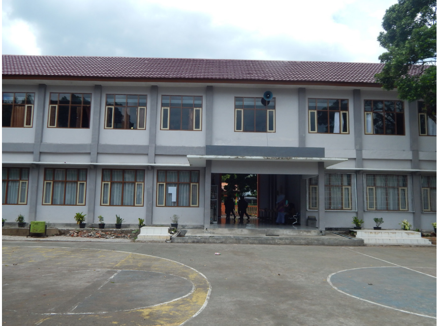
Bangunan di sisi lain SMAN 1 Rejang Lebong
