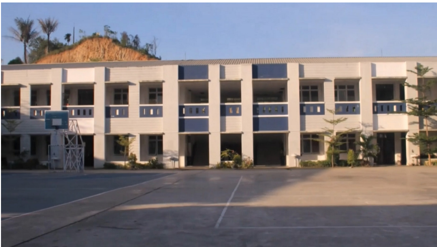
Bangunan SMA N 1 Samarinda saat ini
